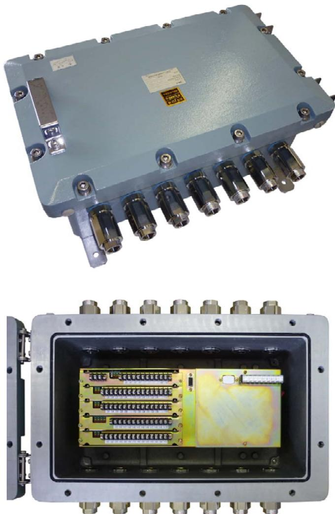
シリアル I/F を搭載する機器を複数接続し、自在に通信及び制御を行います。
