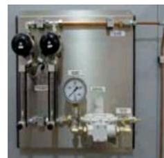
不燃性の保護ガス反応ガスのガスバージシステム
