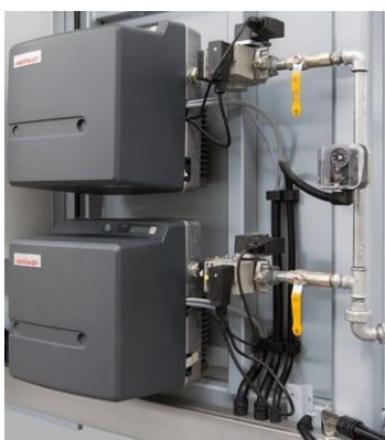
炉加熱とサーモ・アフターバーニング用ガスバーナー
