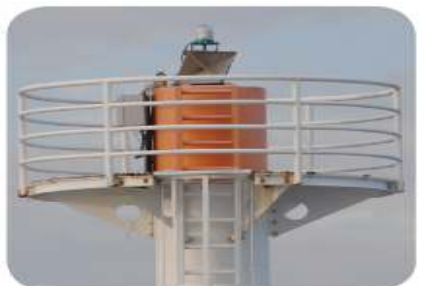
イスラエル、パイロン設置
